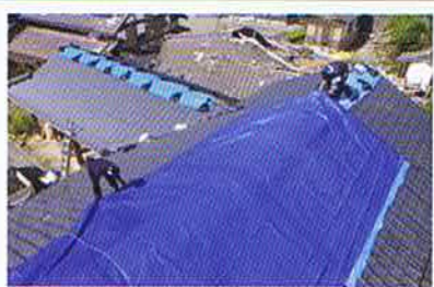
破損した屋根にブルーシートをかける
