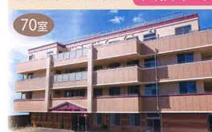
堺市堺区大仙中町 7-12
