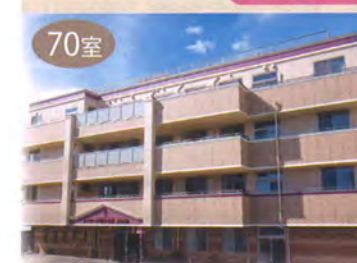
堺市堺区大仙中町 7-12
