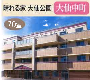
堺市堺区大仙中町 7-12
