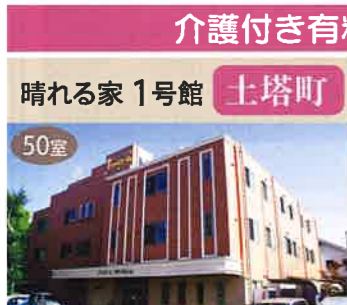
晴れる家 1号館 土塔町
