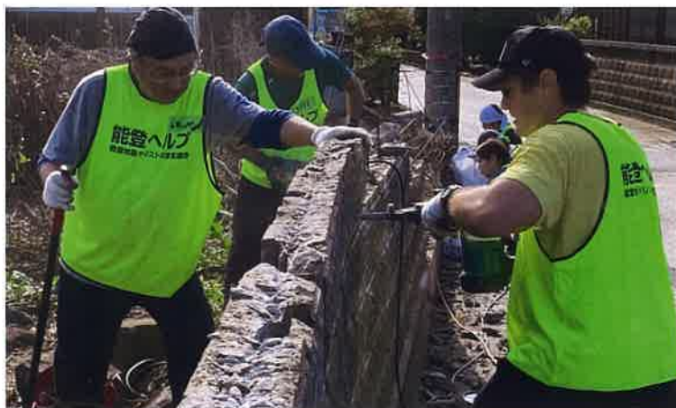
能登ヘルプのボランティアとして被災地の塀の除去作業を行う
