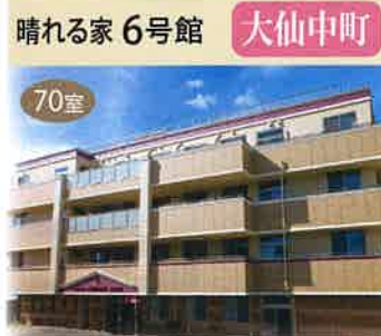
堺市堺区大仙中町 7-12
