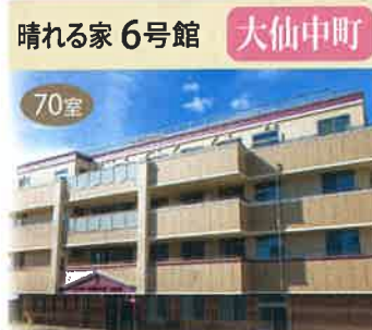
堺市堺区大仙中町 7-12
